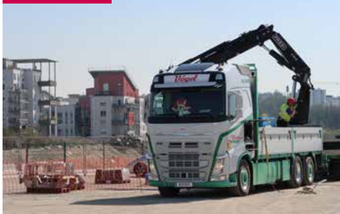
Travaux préparatoires de la station Temps Durables* à Limeil-Brévannes
